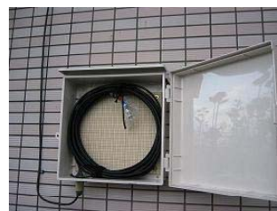
ケーブル収納箱の中。SMA/BNCどちらの形状のハンディ機でも接続できるよう配慮されている。(弥富市役所HPより)
