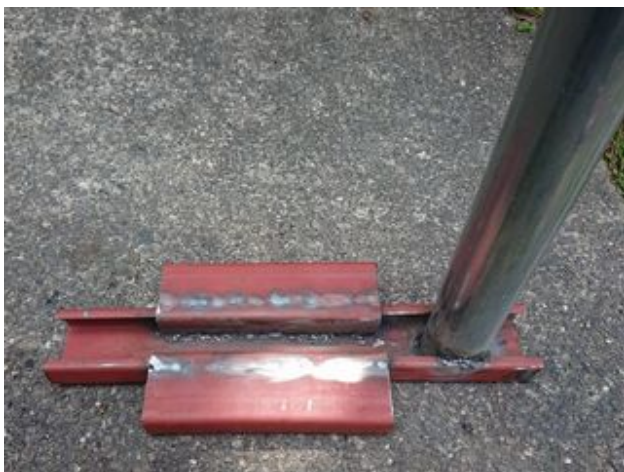
なんとか溶接完了
