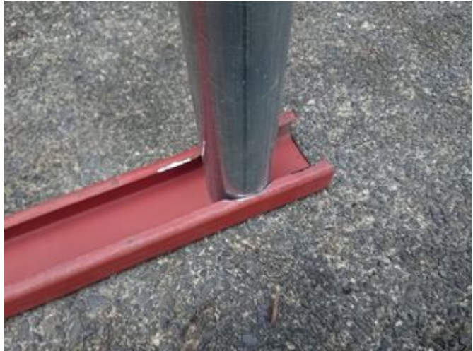
パイプをはめ込んで確認
