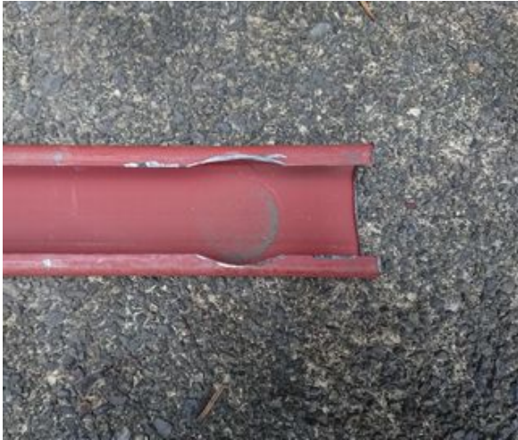
スキマにパイプが入る様、グラインダーで削る
