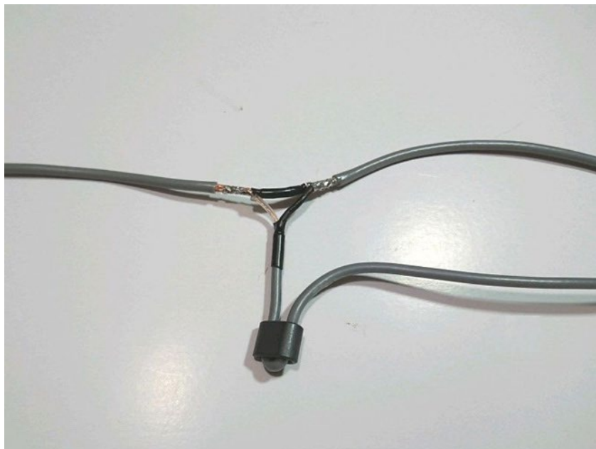
T 字管内で短絡しないよう絶縁処理を確実に
