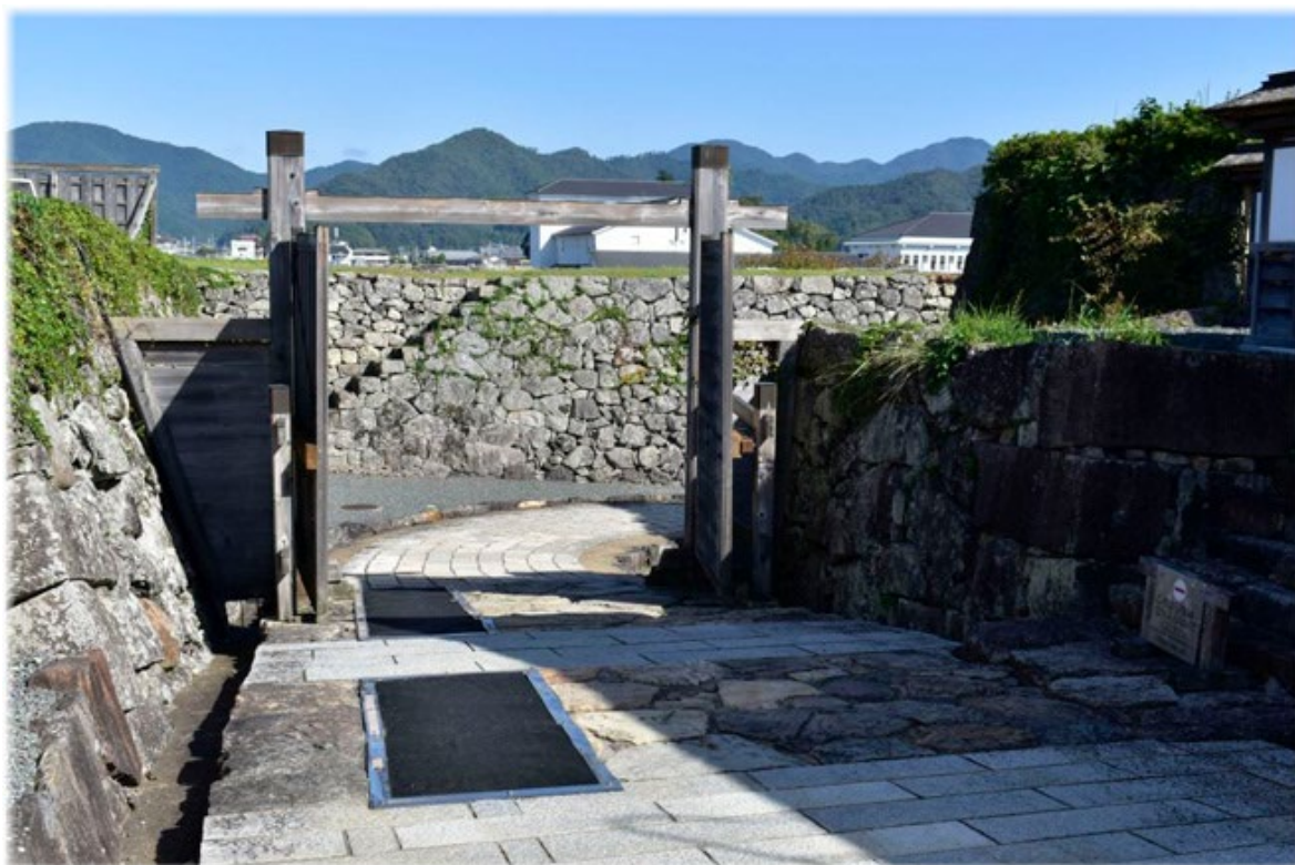
反対側(大書院側)から鉄門跡(くろがねもんあと)を見たところ。石畳の通路は左右ジグザグに曲がっていて、ここを通過して攻め入ろうとする敵を壁の上から攻撃できるようになっています。
